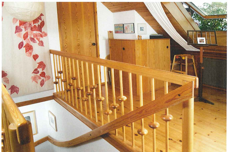
Hier haben Schreiner und Drechsler zusammen gearbeitet: Das Treppengeländer fügt sich wie ein Möbelstück in den Raum ein
